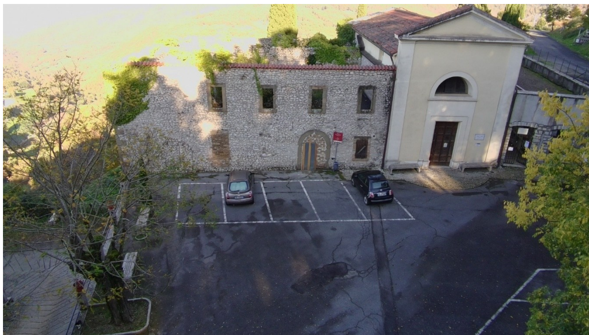
Veduta della facciata della Chiesa di San Rocco – Rocca Massima
