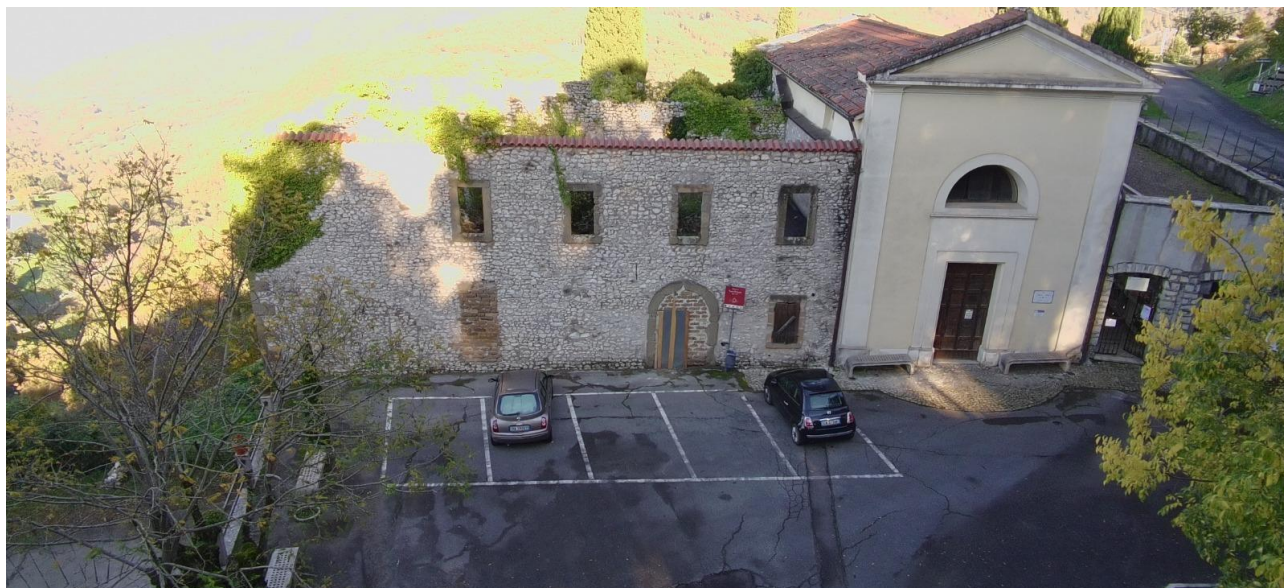
Figura 2 - Veduta della facciata di ingresso alla Chiesa di San Rocco situata nel Comune di Rocca Massima (LT)
